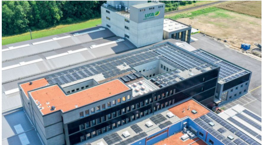
Das neue Agrarzentrum Lyssach ist das grösste Saatgutlager der Schweiz. Die installierte Photovoltaikanlage produziert jährlich 0,5 Mio. Kilowattstunden Strom. Bild: Ralph Gwerder/Strüby Konzept AG
