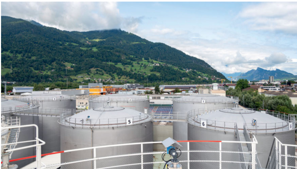
14 AGROLA Tanks ragen in Landquart gut 25 Meter in die Höhe.
